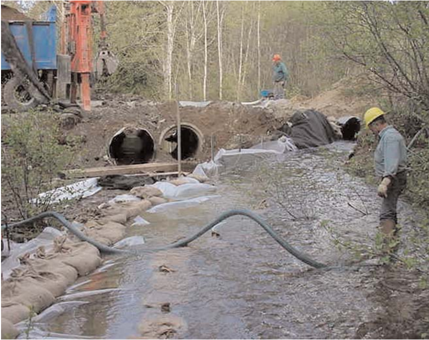
Détournement d'un ruisseau à l'aide d'un batardeau - photo courtoisie de AV Group.
