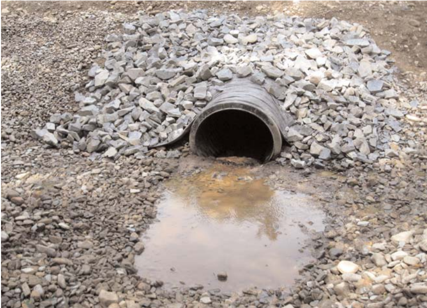
Drain transversal - photo courtoisie de AV Group.
